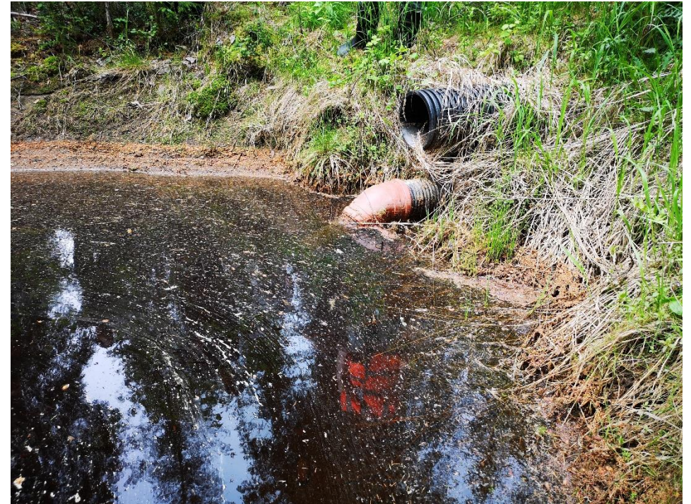
Putkipadoilla voidaan hallita virtaamia. Kuva R.Rahkila
