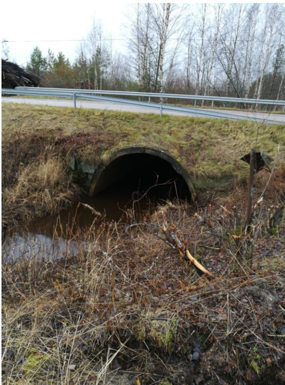
Kuva 3: Isoluiska kulkee Rauhalantien alitse rummussa. Tien vieressä näkyy vesiputken osittain tuhoutunut merkki.
