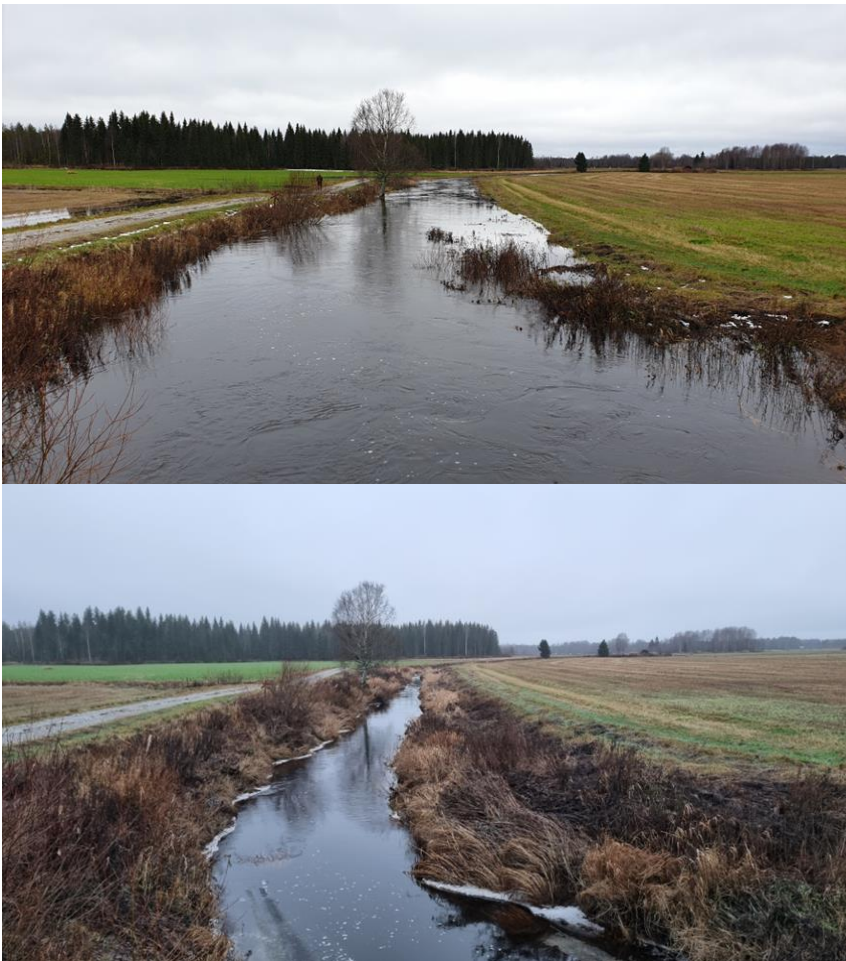
Kuva 4.1 Pylväsoja Syrjäniementien sillalta kuvattuna 21.10.2021 ja 10.11.2021.
