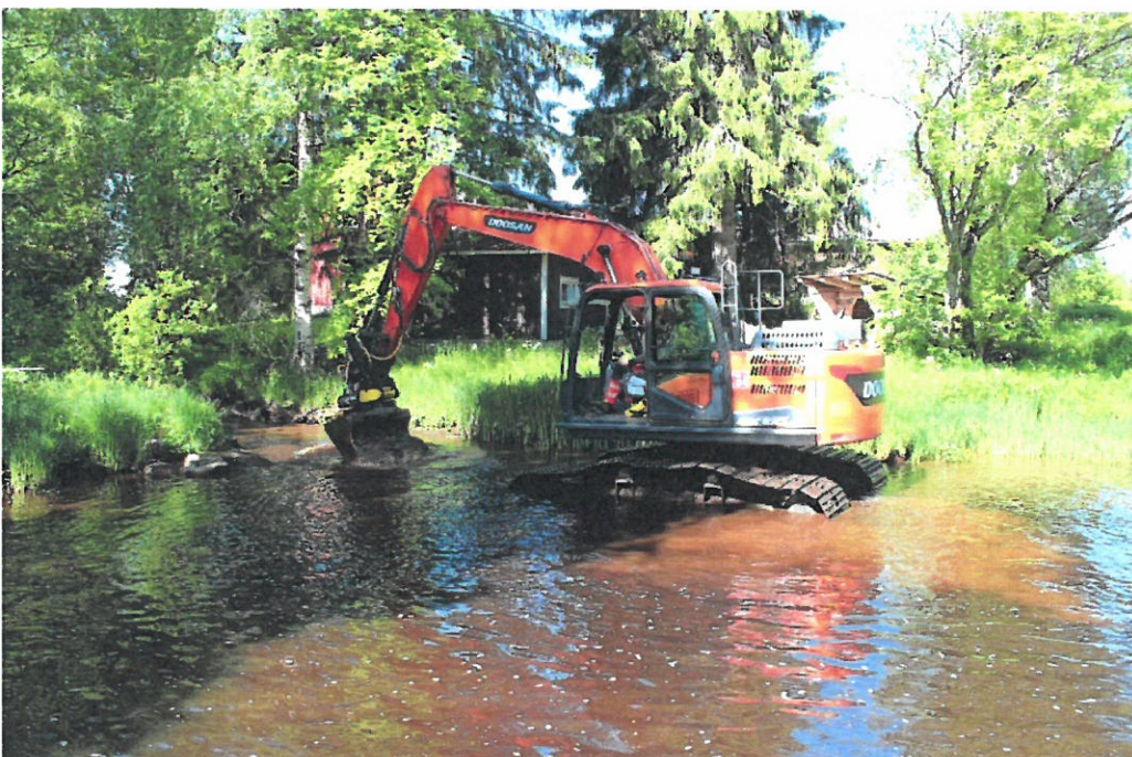
Kuva 9. Kutusoraikkojen muodostamista (Maija Schuss, Ylivieskan kaupungin ympäristöpalvelut).
