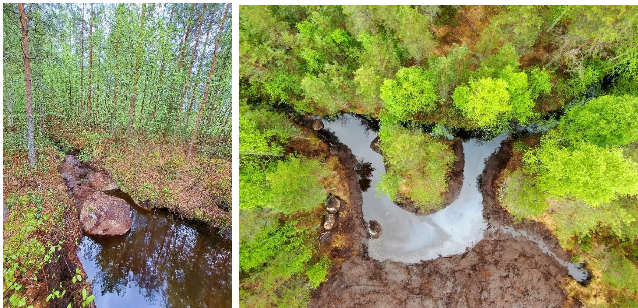
Kuva 7. Hirvenhautakankaan laskeutusallas ja luonnonkivistä rakennettu pohjakynnyys heti kaivuutöiden valmistuttua kesäkuussa 2025 (kuvat Elina Kajava).
