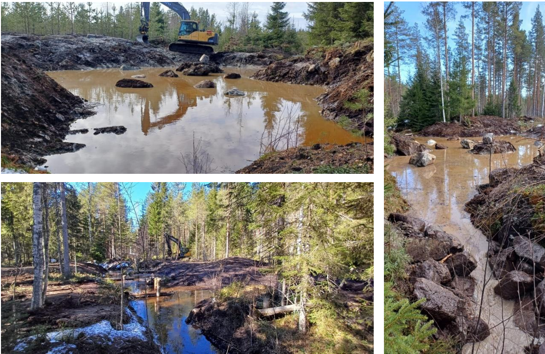
Kuva 5. Viivytyksaltaiden rakentamista keväällä 2025 (kuvat Markus Niskanen).
