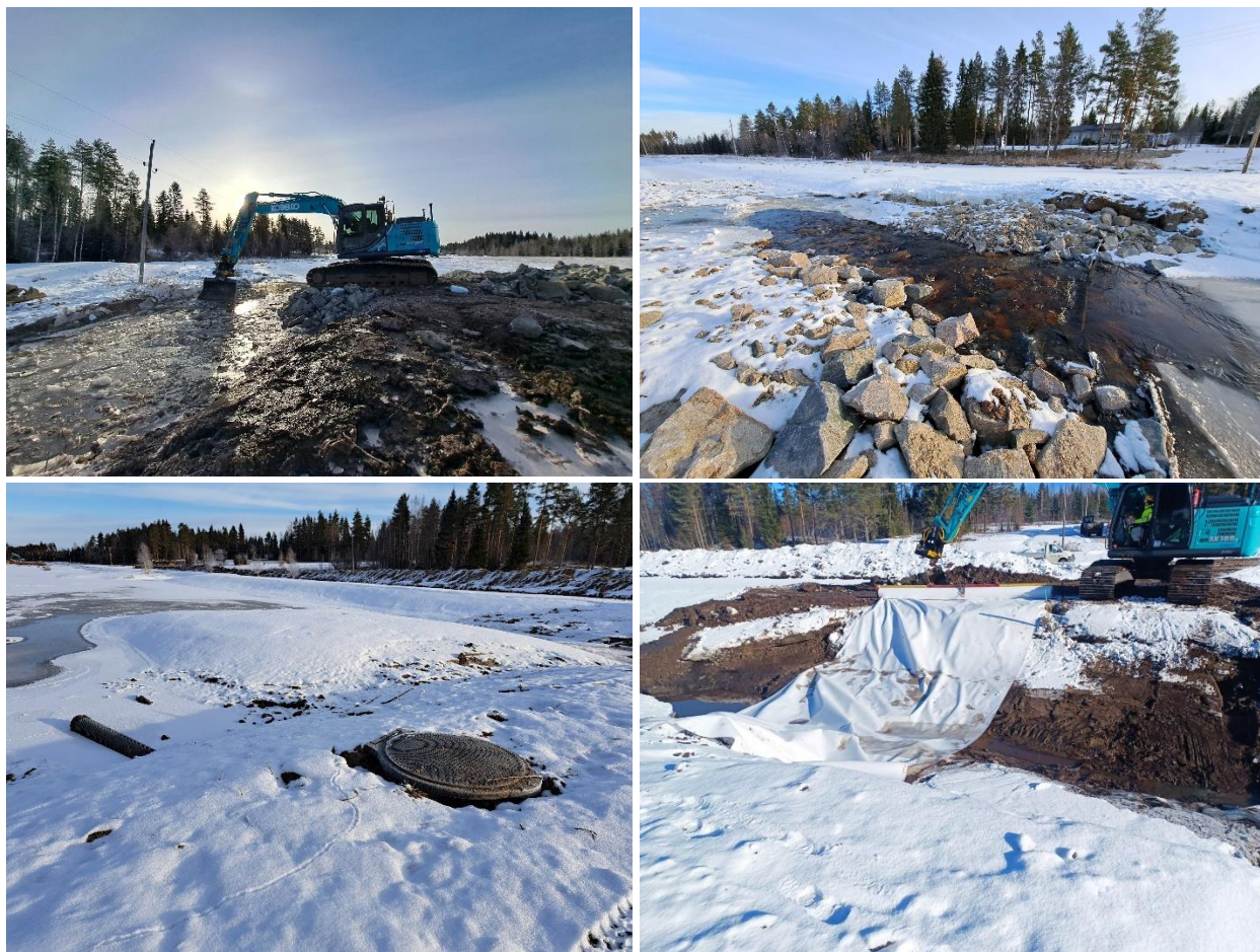
Kuva 12. Latvalan kosteikon työmaa maaliskuussa 2025 (kuvat Elina Kajava).
