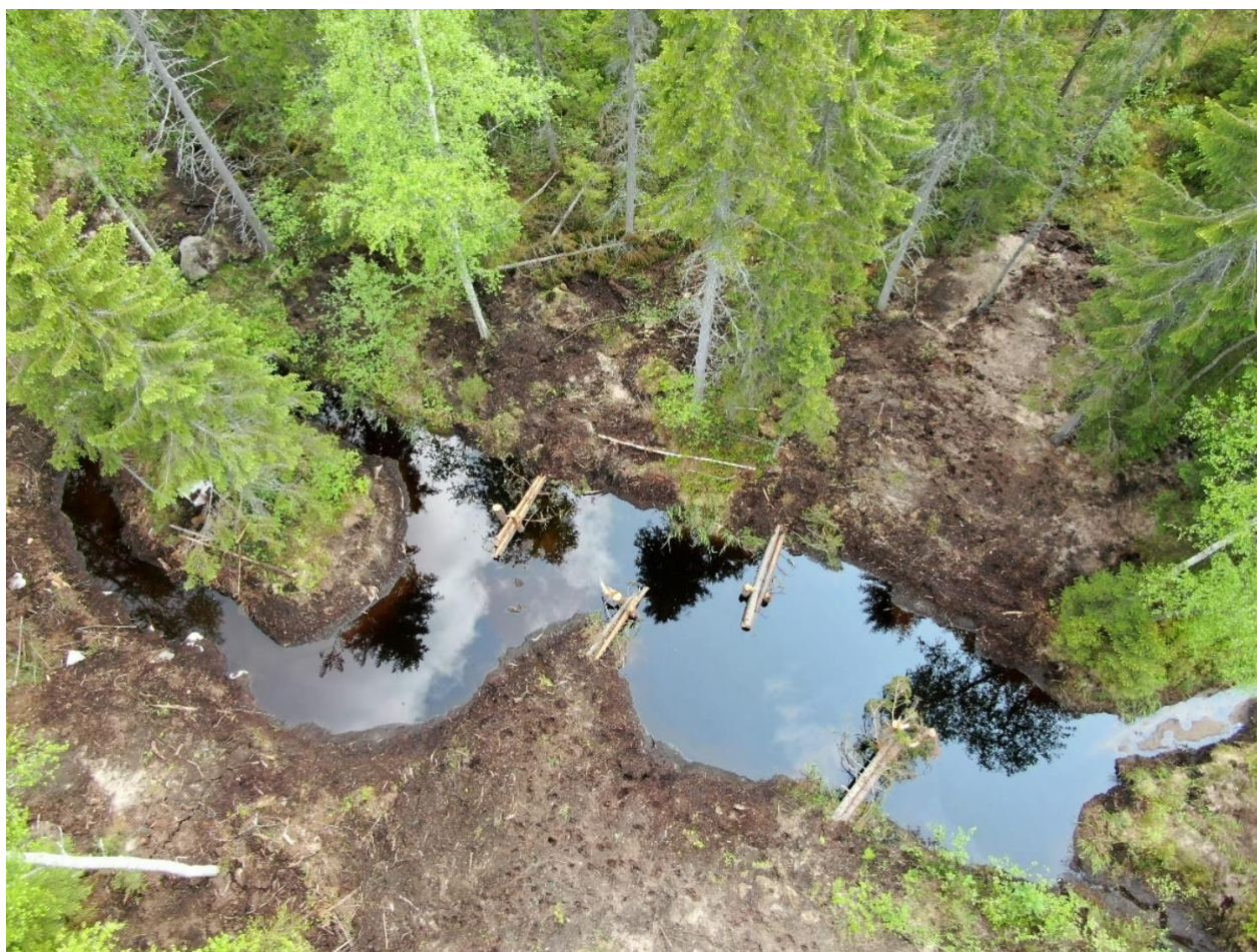
Kuva 8. Pippirinkankaan allas kuvattuna kesäkuussa 2025. Vesi poistuu altaasta luonnonkivistä ladotun pohjakynnyksen kautta Laskeutusaltaalle jätettiin uppopuuta virranohjaimeksi ja sitomaan ravinteita vedestä (kuva Elina Kajava).
