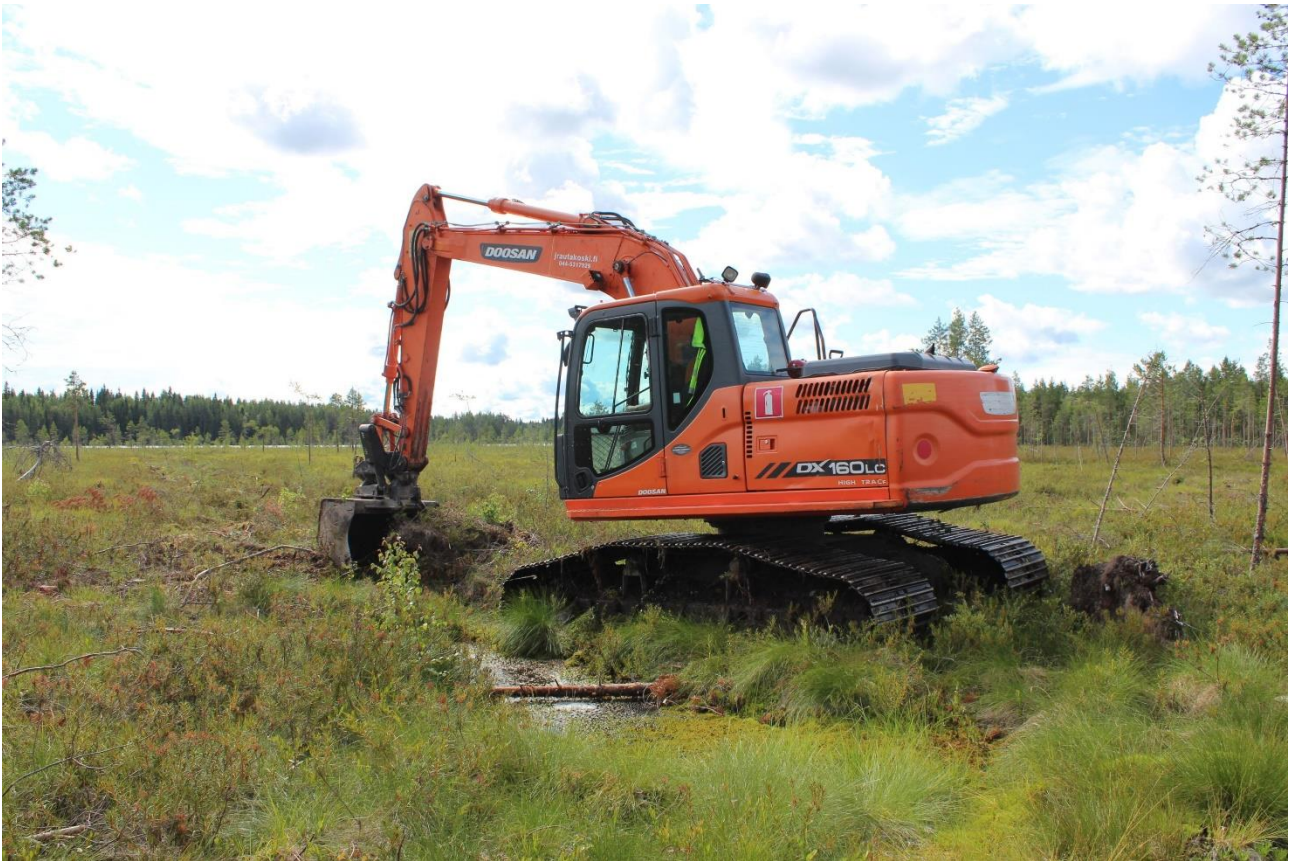
Kuva 3. Lampinnevan sarkaojien täyttöä kaivinkoneella. Kuva: Maija Schuss, Ylivieskan kaupungin ympäristöpalvelut.
