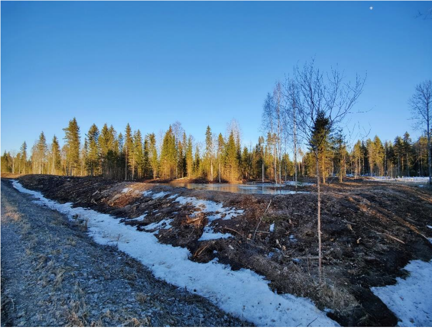
Kuva 18. Metsäinen viivytyskosteikko huhtikuussa 2024 Huhjantieltä kuvattuna. Etualalla alueen rajaava suojapenkere. Alueelle ei vielä ohjattu Salmelanojan vettä (Elina Kajava, Ylivieskan kaupungin ympäristöpalvelut 2024).
