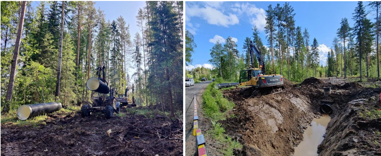
Kuva 20. Metsäiselle viivytyskosteikolle johtavan rumpuojan asennusta kosteikon itäpuolella. Rumpuputki alittaa myös Huhjantien (Elina Kajava, Ylivieskan kaupungin ympäristöpalvelut 2024).
