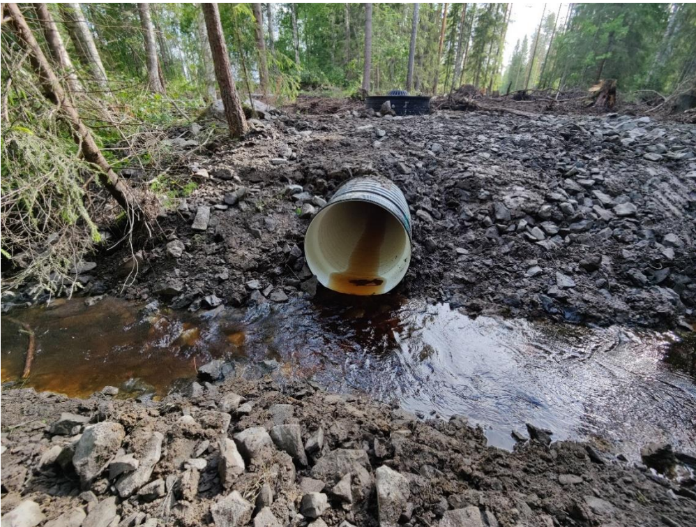
Kuva 22. Viivytysalueelle johtavan rumpuojan alkupiste Salmelanojan varressa. Salmelanojan vettä ohjataan metsäiselle viivytyskosteikolle ensin rumpuojaa ja sittemmin avouomaa pitkin. Putken kohdalle Salmelanojaan on rakennettu kuvassa näkyvä pohjakynnys (Elina Kajava, Ylivieskan kaupungin ympäristöpalvelut 2024).
