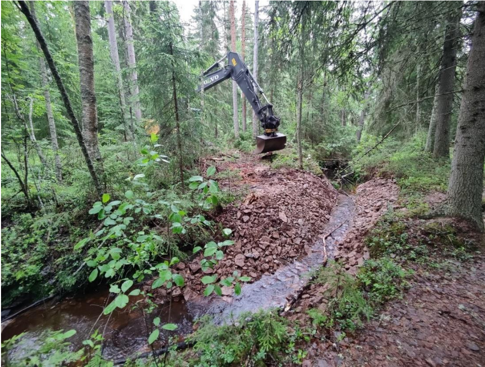
Kuva 26. Töiden viimeistely käynnissä Joonalan kohteella kesäkuussa 2024 (Elina Kajava, Ylivieskan kaupungin ympäristöpalvelut 2024).
