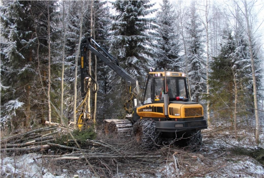
Kuva 17. Puuston poisto ojalinjalta ja penkereen kohdalta lähti käyntiin lokakuun 2023 lopussa kaupungin metsäisellä viivytysalueella (Maija Schuss, Ylivieskan kaupungin ympäristöpalvelut 2023).
