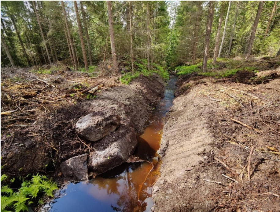
Kuva 25. Jylynevan maarakenteinen pohjakynnys juuri valmistuttuaan kesäkuussa 2024 (Elina Kajava, Ylivieskan kaupungin ympäristöpalvelut 2024).
