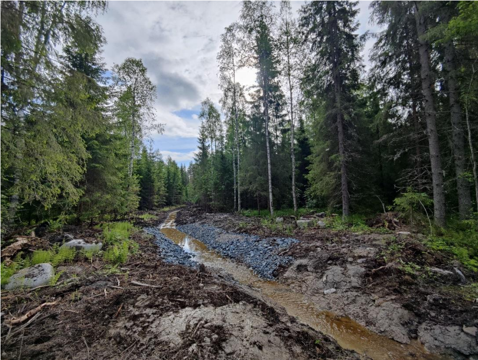
Kuva 23. Metsäiselle viivytyskosteikolle johtava avouoma kesällä 2024 (Elina Kajava, Ylivieskan kaupungin ympäristöpalvelut 2024).
