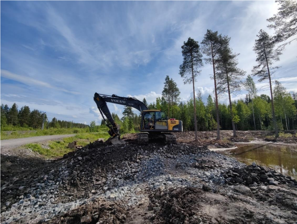
Kuva 21. Kaivinkone viimeistelemässä metsäisen viivytysalueen töitä kesäkuussa 2024 (Elina Kajava, Ylivieskan kaupungin ympäristöpalvelut 2024).
