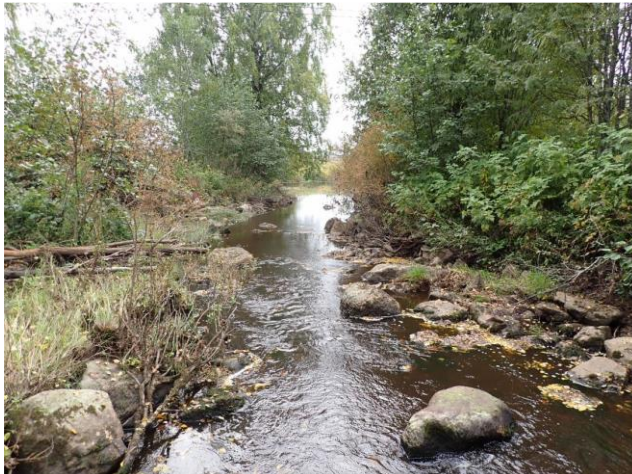
Kuva 29. Uudelleen kivetty koski, virtausta ohjattu, myös rantauomaan. Kuva Heikki Tahkola
