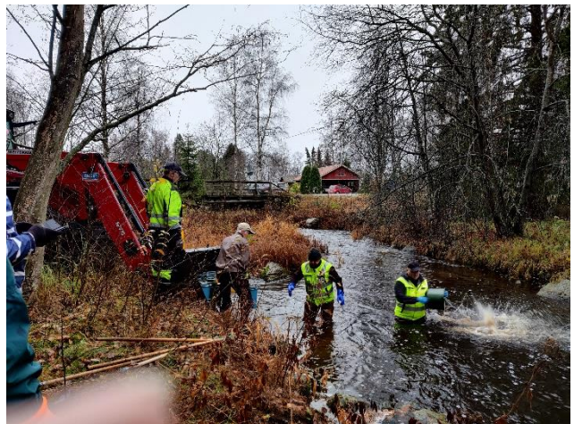
Kuva 5. Sorat levitettiin suunniteltuihin kohtiin.
