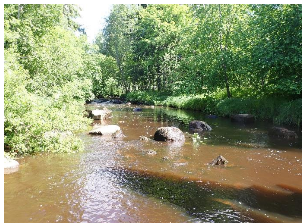
Kuva 16. Rännimäinen niva muotoiltiin moni-ilmeisemmäksi ja siihen tehtiin syvänekuoppia. Kuva Heikki Tahkola
