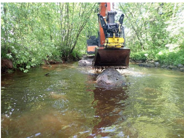
Kuva 15. Isommat kivet ”istutettiin” hieman upoksiin, jotta ne eivät olisi liian silmiinpistäviä matalan veden aikana. Kuva Heikki Tahkola
