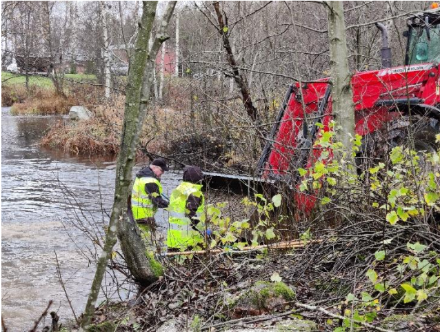
Kuva 6. Osa kohteista voitiin soraistaa suoraan traktorin kauhasta. Kuva: Liisa Ängeslevä
