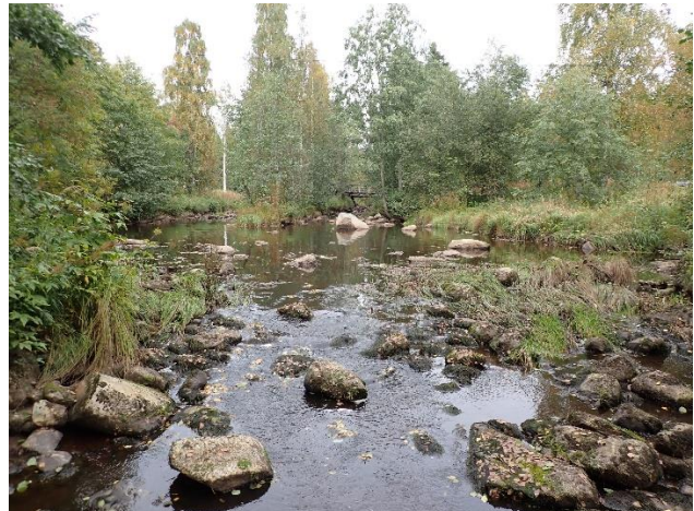
Kuva 27. Myllysaaren länsiväylään tehtiin alivirtaama uoma, joka mahdollistaa kalojen liikkumisen myös alivirtaama-aikana. Kuva Heikki Tahkola
