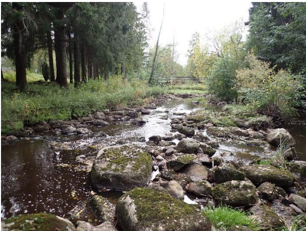
Kuva 22. Lohkarekasaumia leviteltiin koko uomaan. Kuva Heikki Tahkola
