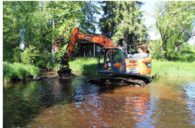
Kuva 12. Pylväänlammeesta poistettua soraa voitiin hyödyntää Pylväänlammeesta lähtevien uomien niskoille tehtäviin kutusorakoihin.
