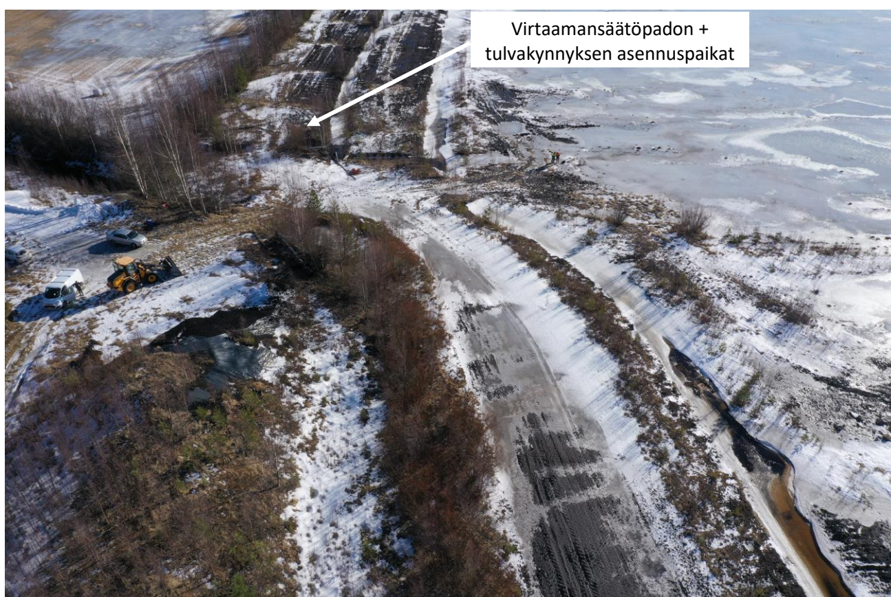
Kuva 5. Pienoiskopterikuva osa-alueen 1 itäreunalta patolaitteiden asennuspaikalta 16.3.2020.
