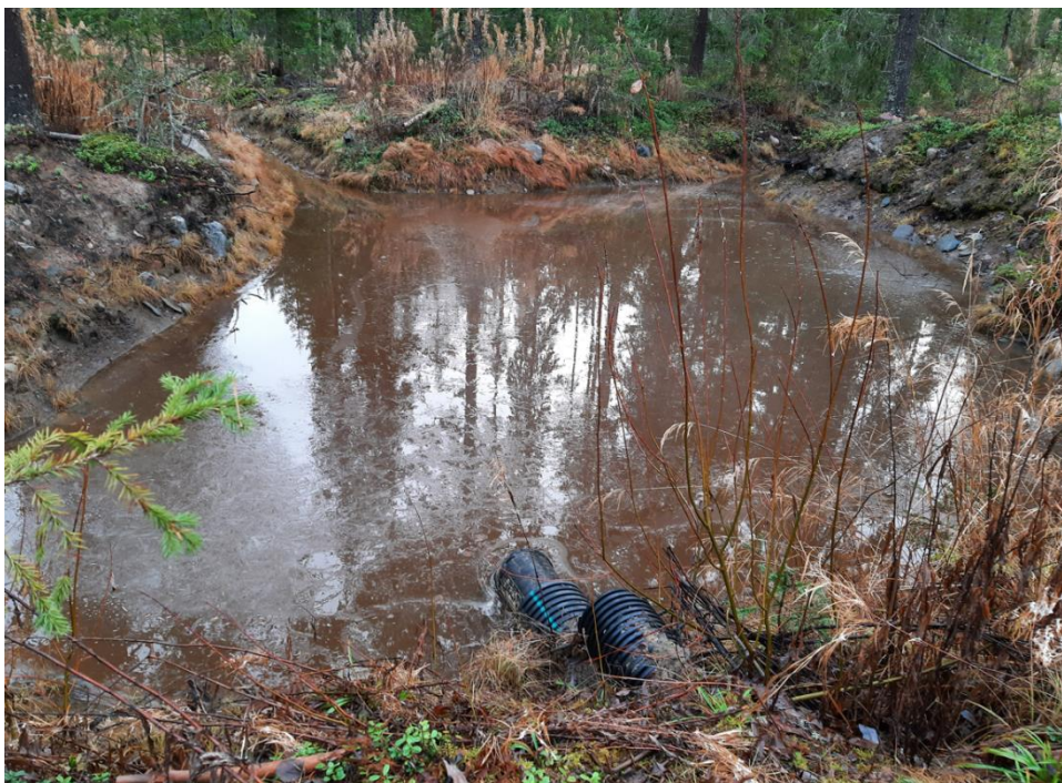
Kuva 5 Kohteelle on tehty allas ja putkipato kunnostusojitusten yhteydessä.
