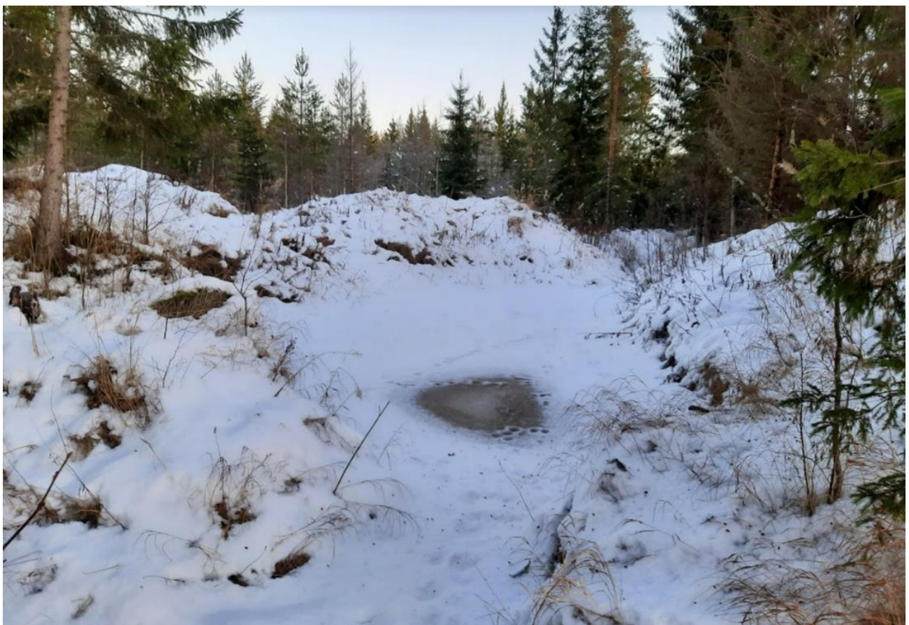
Kuva 8 Kohteella oleva allas laajennetaan ja kunnostetaan
