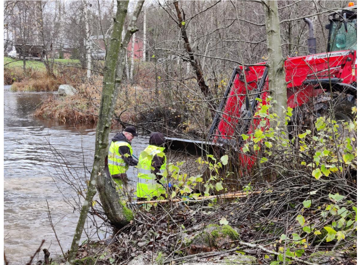
Myllysaaren kosken niska soraistettiin koko uoman leveydeltä talkoilla
