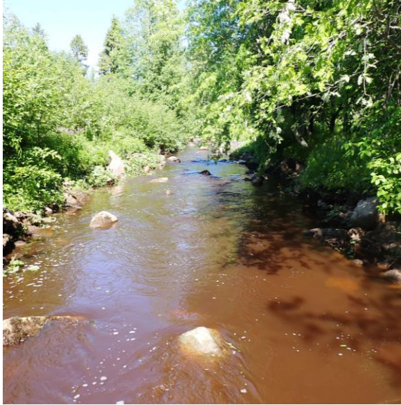
lisätty kosken syvyysvaihtelua syvänekuoppien avulla, paikoitellen koskipinta-alaa lisätty leventämällä uomaa...
