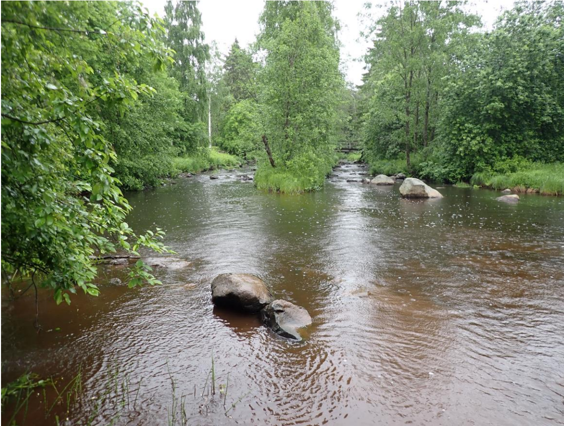
Onnelansillan alapuolinen koski alavirrasta kuvattuna, vasemman puoleinen rännimäinen uoma moni-ilmeistetty kiveämällä
